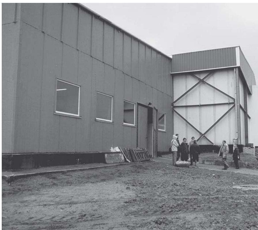
Widok ściany frontowej budynku hali technologicznej oczyszczalni ścieków i utylizacji odpadów Zakładu SUPER FISH w Kukini koło Ustronia Morskiego.
