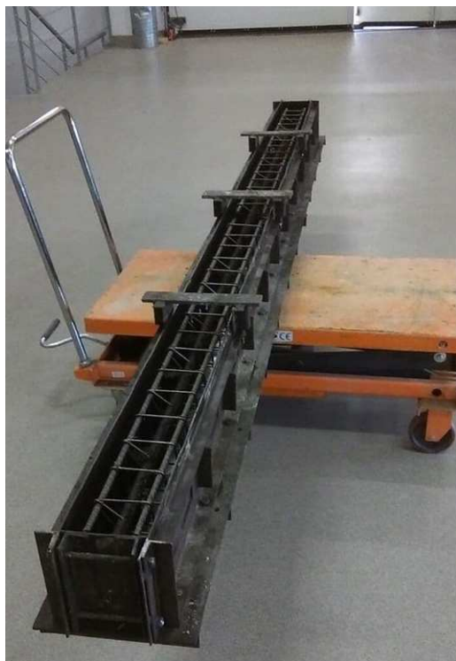
Rys. 5.5 Ogólny widok szkieletów zbrojenia w formie przed betonowaniem
