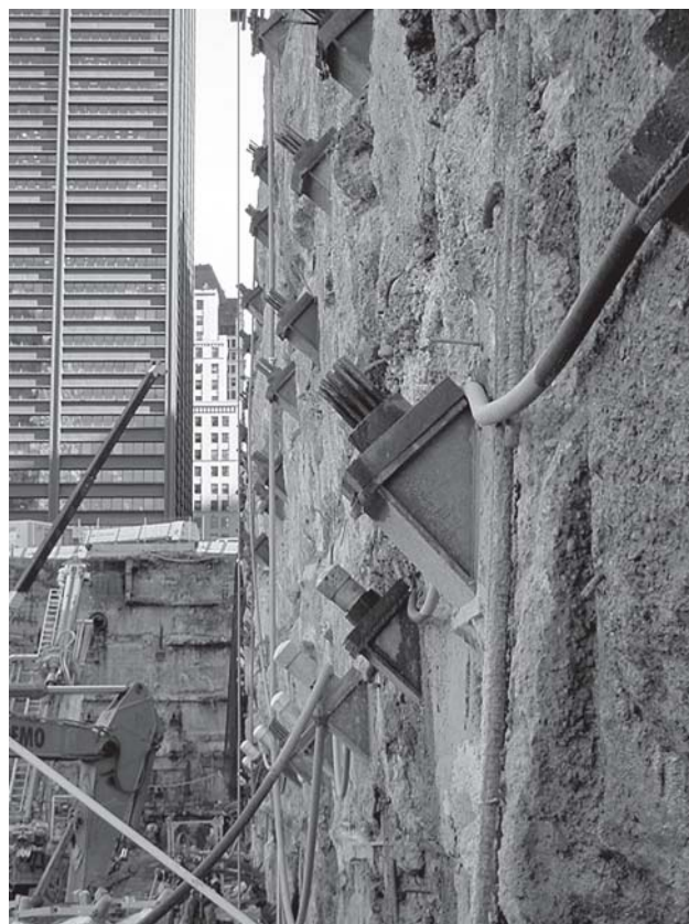
Południowa ściana – zakotwiczenia
