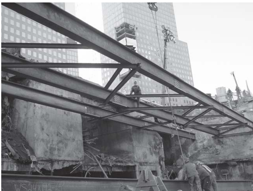
Wzmocnienia ścian zagrożonych zawaleniem
