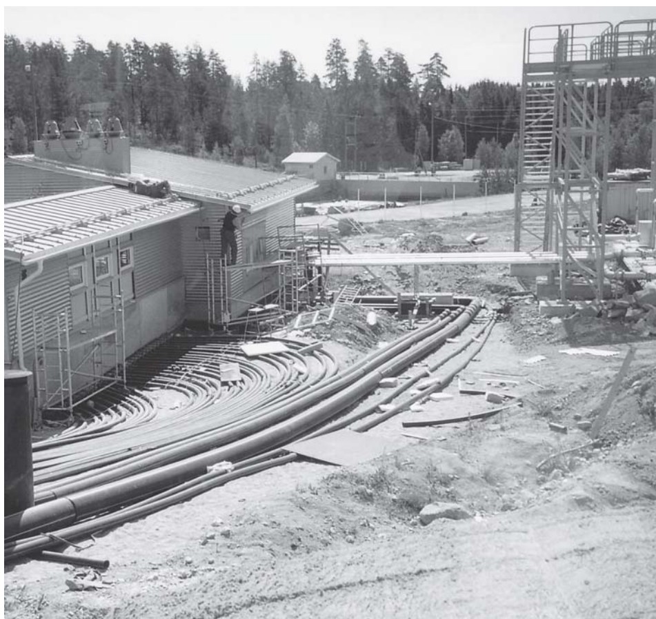
Budowa stacji odzysku gazu wysypiskowego – Helsinki
