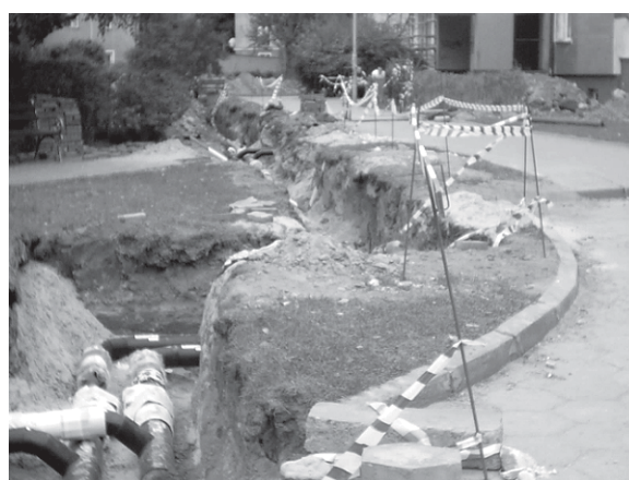
Prace przy modernizacji systemu grzewczego
