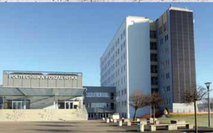
Tak prezentują się zmodernizowane obiekty uczelni od strony ulicy Jana Pawła II.
