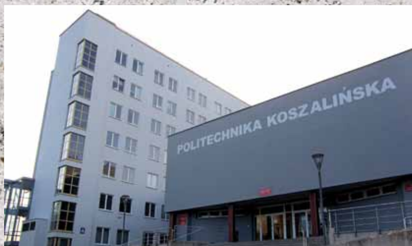
Wejście główne do siedziby uczelni przy ul. Śniadeckich od strony dziedzińca również zostało odnowione.
