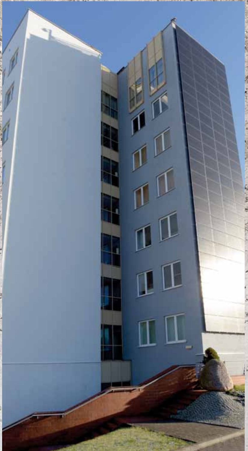
Zamontowane na ścianie czarne panele fotowoltaiczne będą wytwarzać prąd na potrzeby uczelni.
