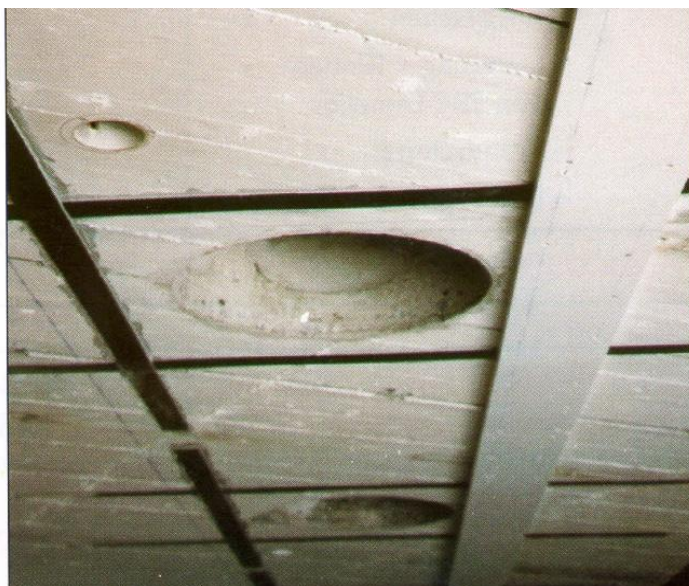
Rys. 3.7. Przykład zabezpieczenia przeciwpożarowego wzmocnienia stropu taśmami CFRP [94]
