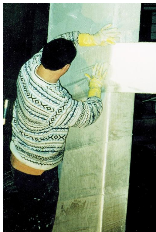
b) wzmacnianie słupa matą na bazie włókien aramidowych w obszarach zagrożonych sejsmicznie
