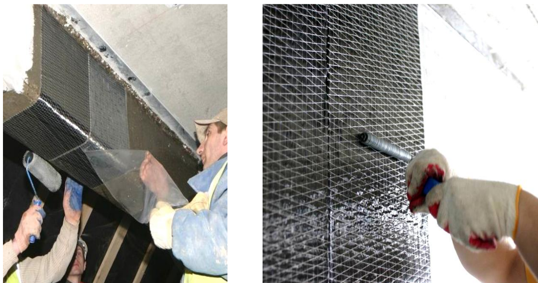
Rys. 2.10. Wzmocnienie elementów ścinanych z wykorzystaniem mat CFRP [94]
