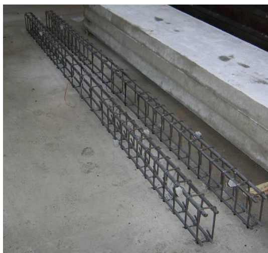
Rys. 5.3. Ogólny widok zbrojenia belek żelbetowych przed ich zabetonowaniem
