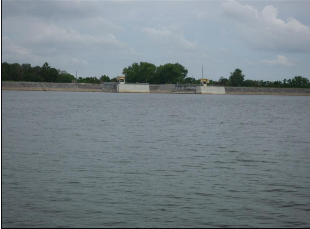
Rys. 31. Zbiornik Turawa - widok na zapórę czołową
