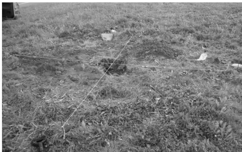
Rys. 49. Odtworzenie położenia punktu ramy geodezyjnej (Źródło:[11])
