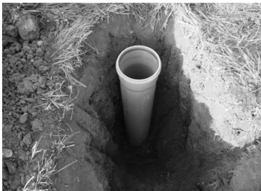
Rys. 47. Rura PCV wykorzystana do stabilizacji punktów ramy geodezyjnej (Źródło:[11])
