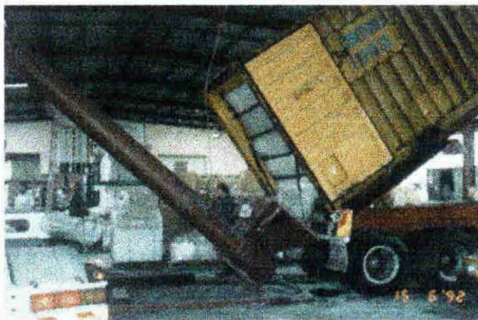
Rys.3.3.1.7. Rozładunek 20-tonowego kontenera z mikrokrzemionką [202]
