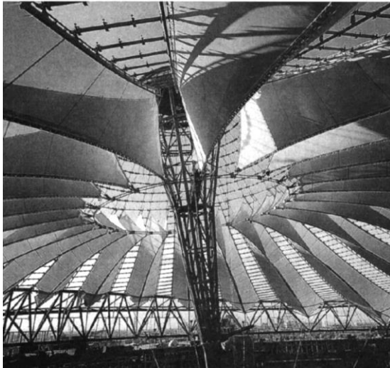
Rys. 1.2. Budowa parasola nad dziedzińcem Sony Center w Berlinie [22]
