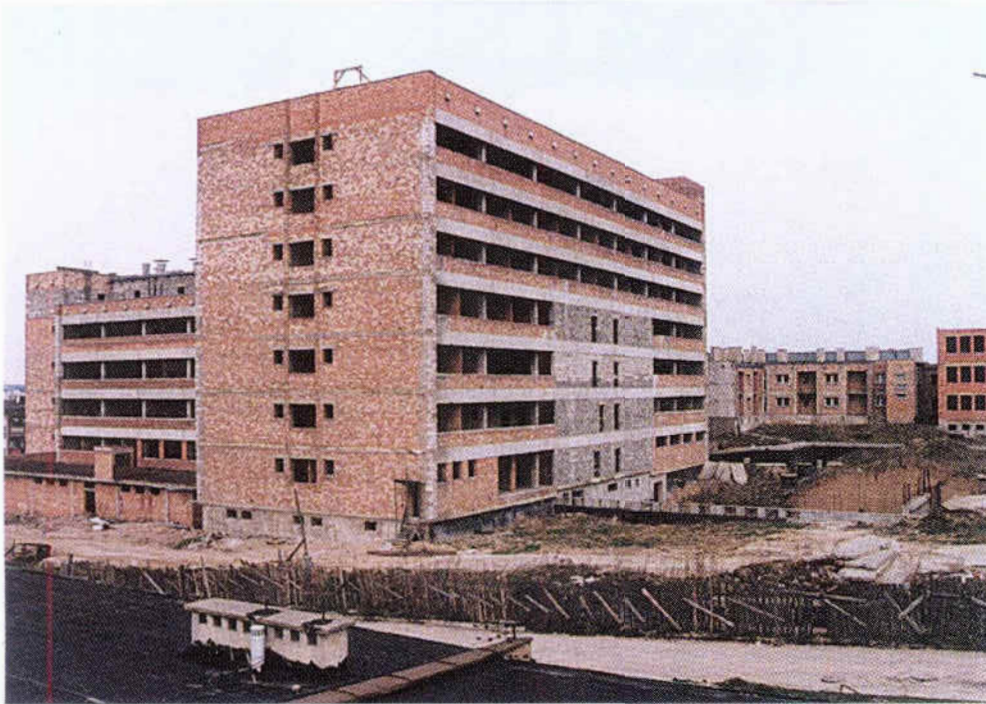
Budynki IZiM w budowie.
