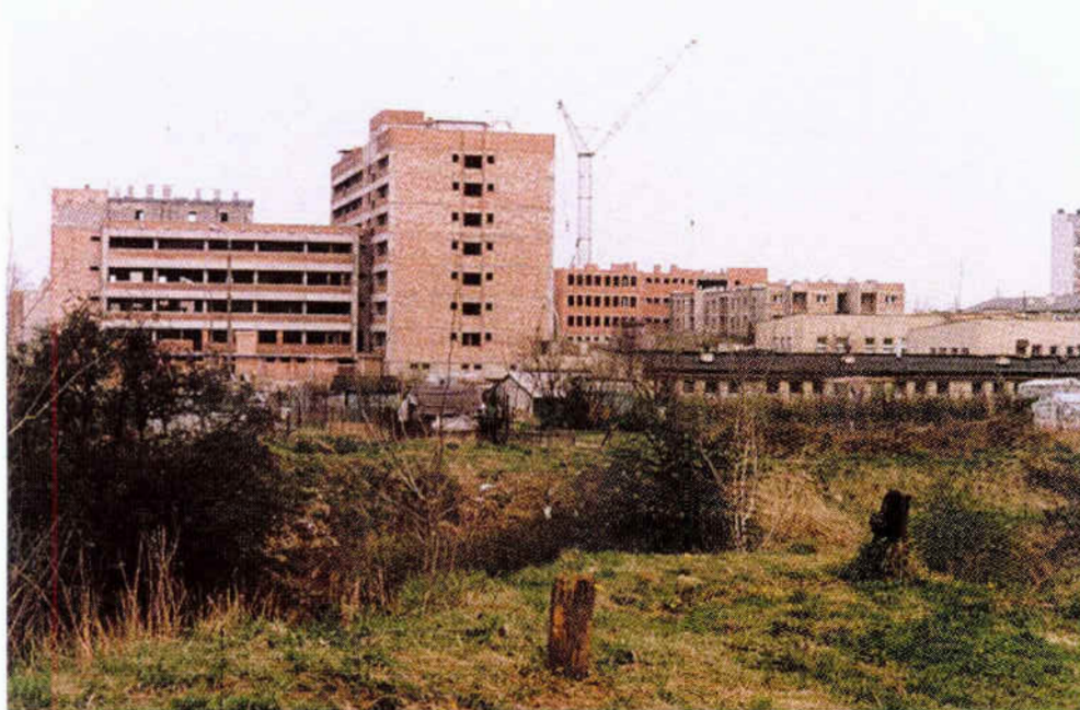
Budynki IZiM w budowie.
