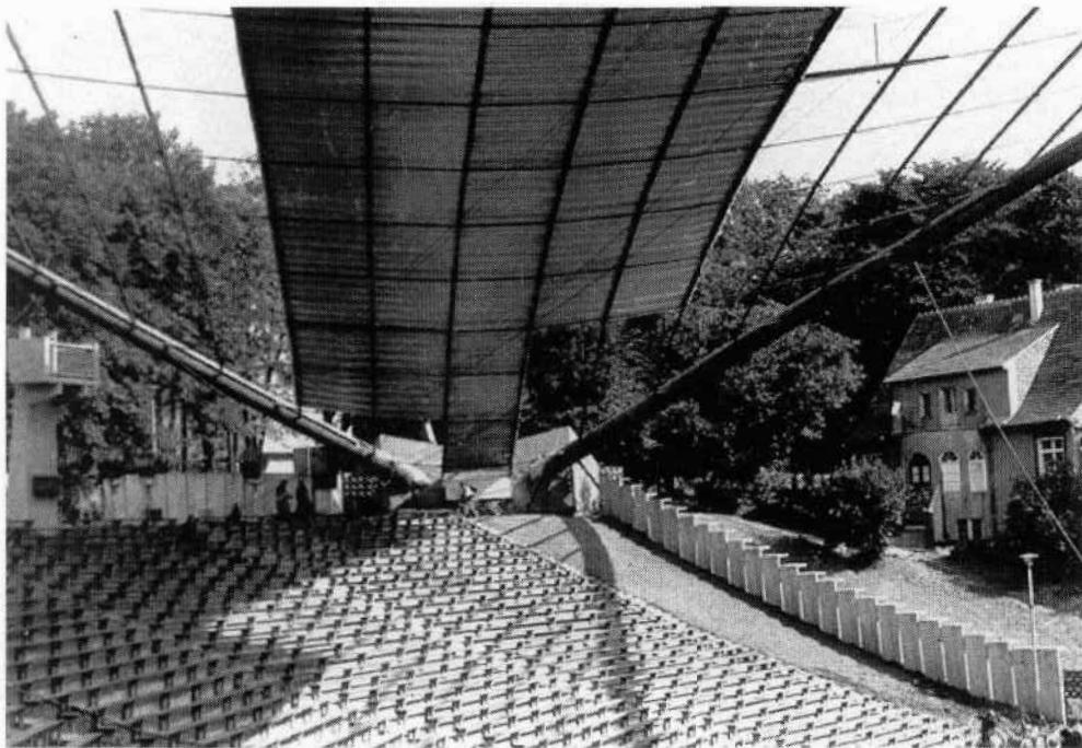
Prace nad pokryciem dachu koszalińskiego amfiteatru według projektu prof. J. Filipkowskiego – 1975 r.
