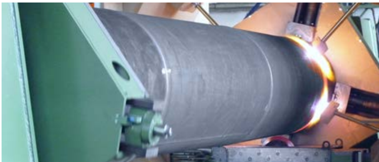
Ryc. 131 Specjalnie skonstruowana automatyczna maszyna do spawania płomienic fałdowanych
