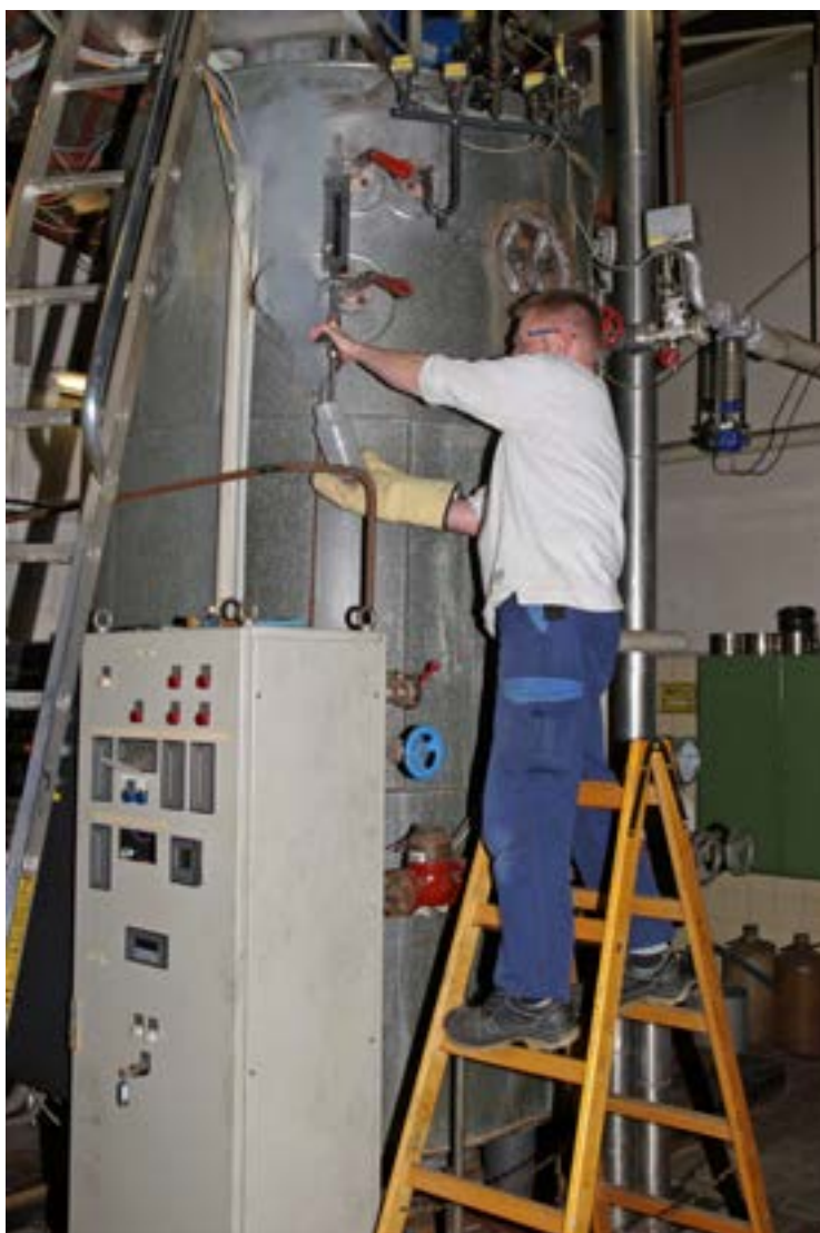
Ryc. 34 Pobór próbek wody bez chłodniczki i z użyciem nieodpowiedniego naczynia
