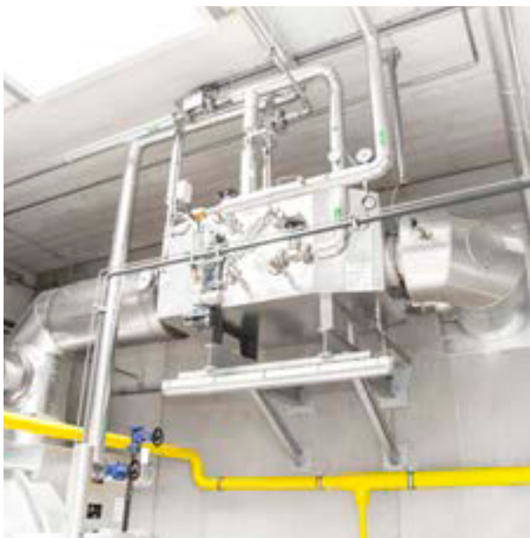
Ryc. 186 Wymiennik ciepła kondensacyjny ECO 6
