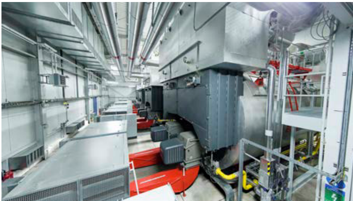
Ryc. 190 Kocioł dwupłomienicowy z modułem przegrzewacza
