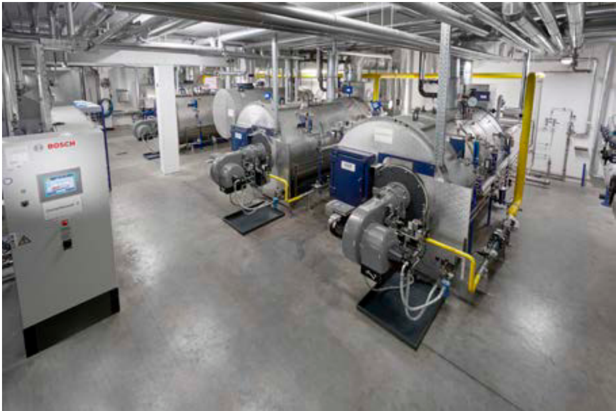
Ryc. 168 Modernizacja działającej dotychczas instalacji wedle najnowszych standardów
