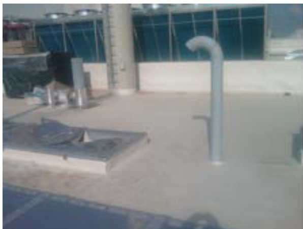
Ryc. 19 Przewody wydmuchowe zaworu bezpieczeństwa
