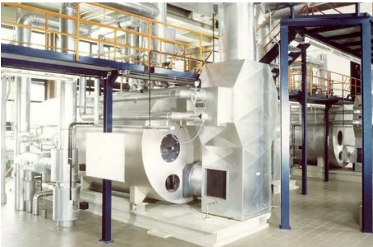
Ryc. 67 Ekonomizer wolnostojący w połączeniu z palnikiem dwupaliwowym (gaz/olej ciężki)
