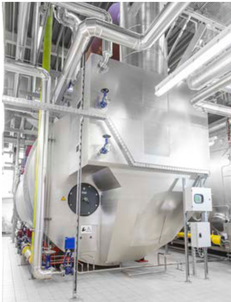
Ryc. 165 Zdejmowana izolacja na otworach rewizyjnych (UL-S ze zintegrowanym ekonomizerem)
