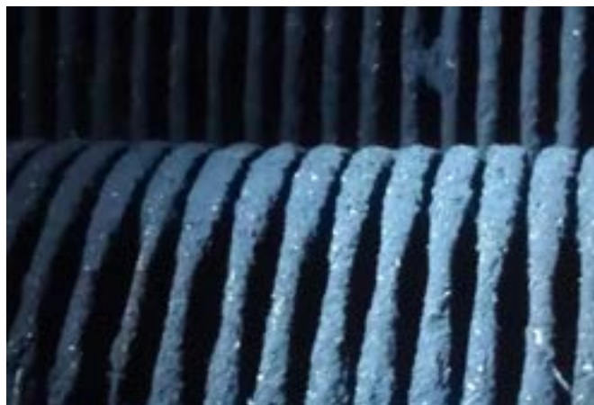
Ryc. 29 Osady na ożebrowaniu ekonomizera
