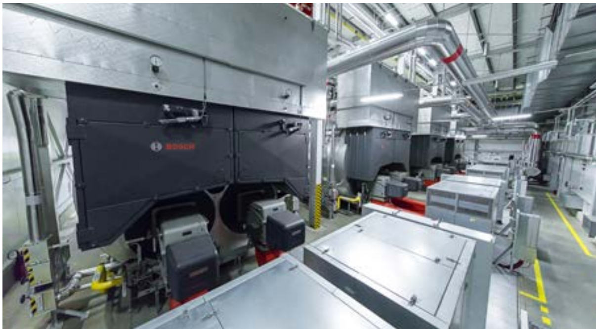
Ryc. 184 Instalacja z kotłami parowymi ZFR/ZFR-X
