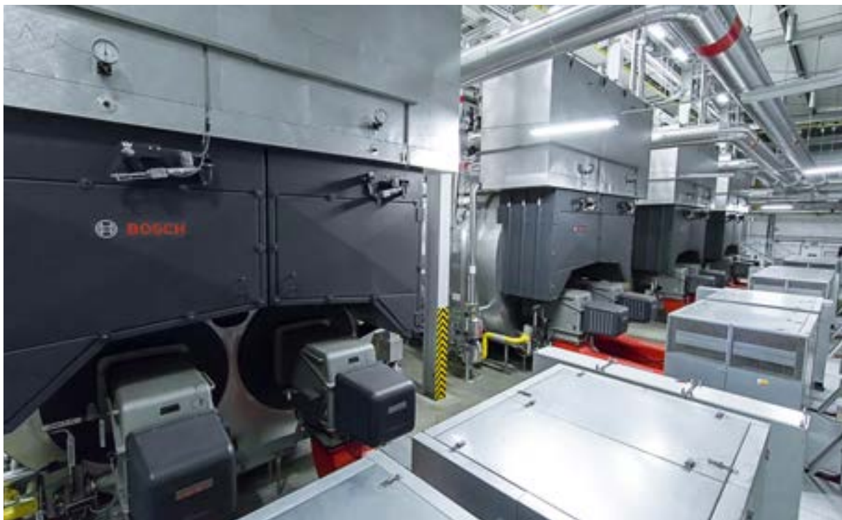
Ryc. 73 Kocioł dwupłomienicowy z modulem przegrzewacza
