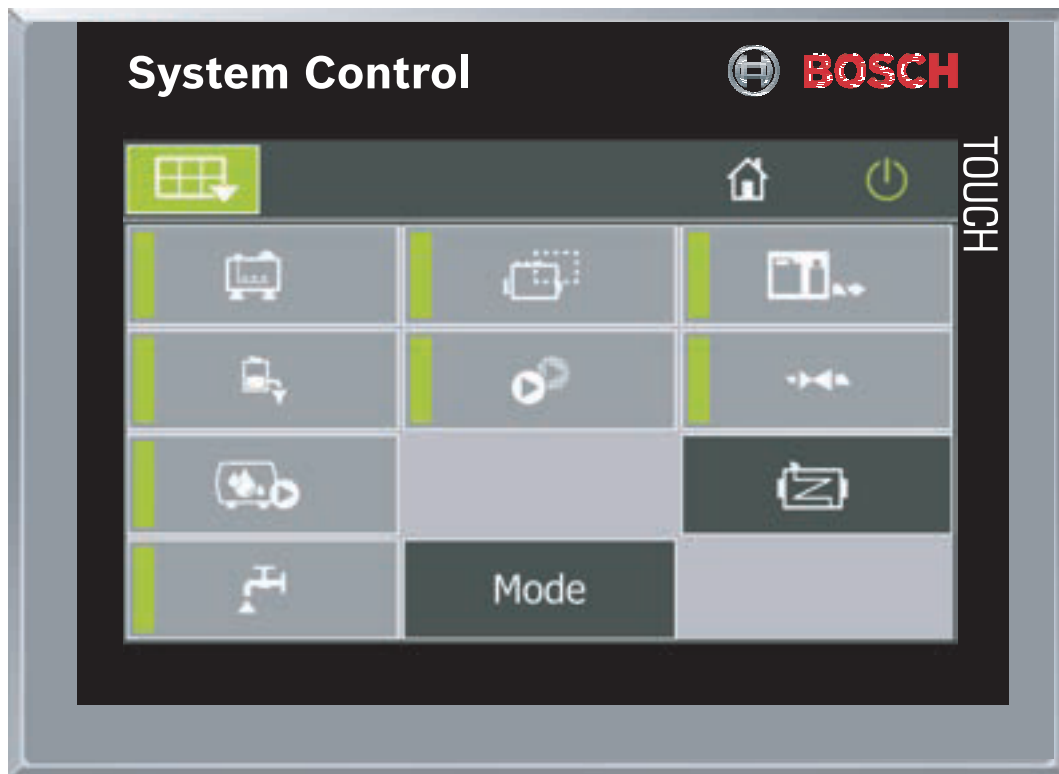
Ryc. 115 Szeroko rozbudowany system zarządzania instalacją SCO – przykładowy wyświetlacz
