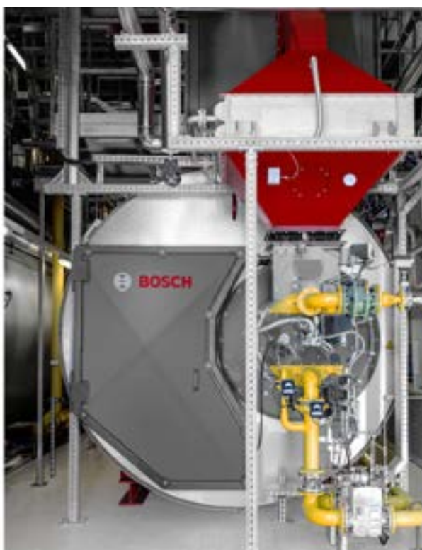
Ryc. 211 Moduł podgrzewania powietrza APH zainstalowany na kotle
