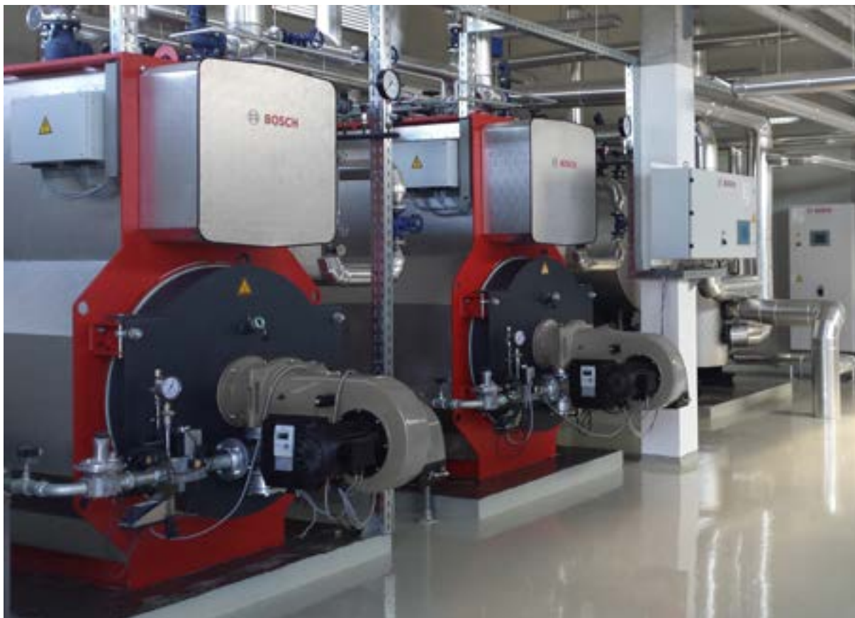
Ryc. 176 Instalacja z kotłami U-MB
