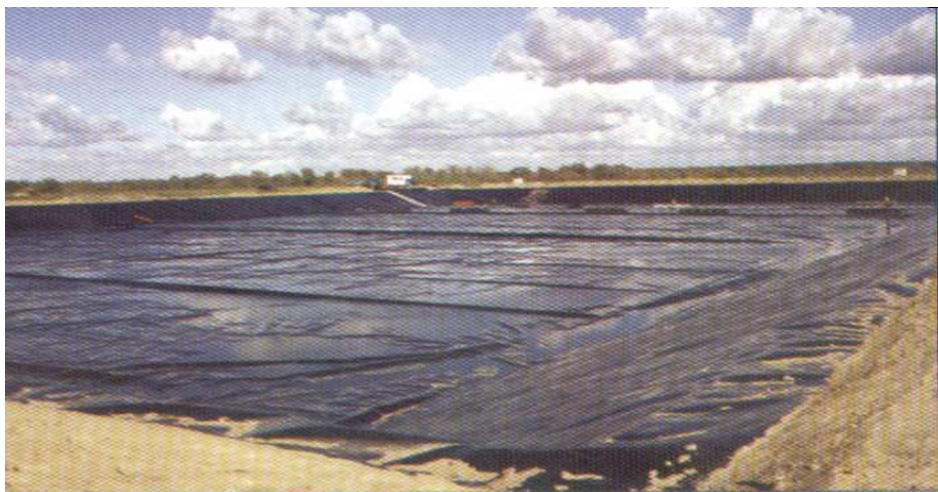
Rys. 14. Dno zbiornika wyłożone folią typu PEHD gr. 1,5 mm „geomembrana”
