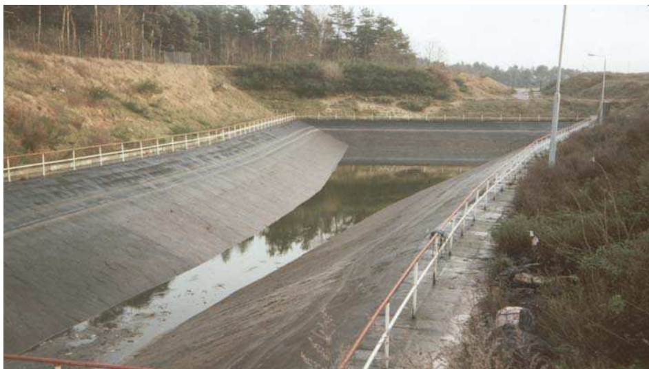
Rys. 15. Staw stabilizacyjny na odcieki wysypiskowe Fig. 15. Stabilization pond for landfill leachates
