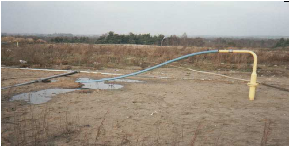
Rys. 11. Odwiert z fragmentem instalacji odgazowującej
