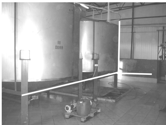
Rys. 6. Osadniki typu Dorra nr III i V w hali podczyszczania ścieków firmy SUPERFISH – strefa prowadzonych badań
