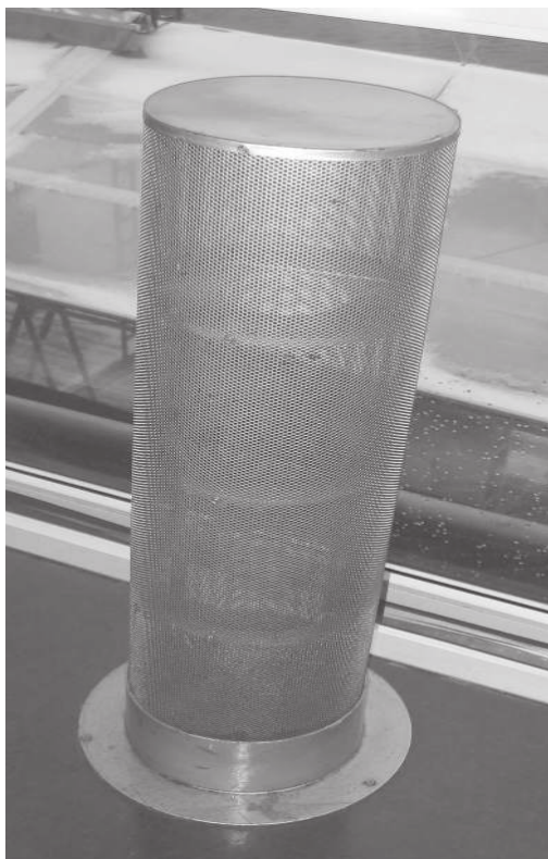
Rys. 8. Urządzenie do dopływu powietrza działające na zasadzie „zatapiania” Fig. 8. Supply air outlet, working by “a flooding” principle
