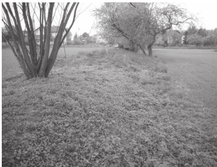
Rys. 3. Wał przeciwpowodziowy, km 18,130÷18,230 biegu rzeki Piotrówki
