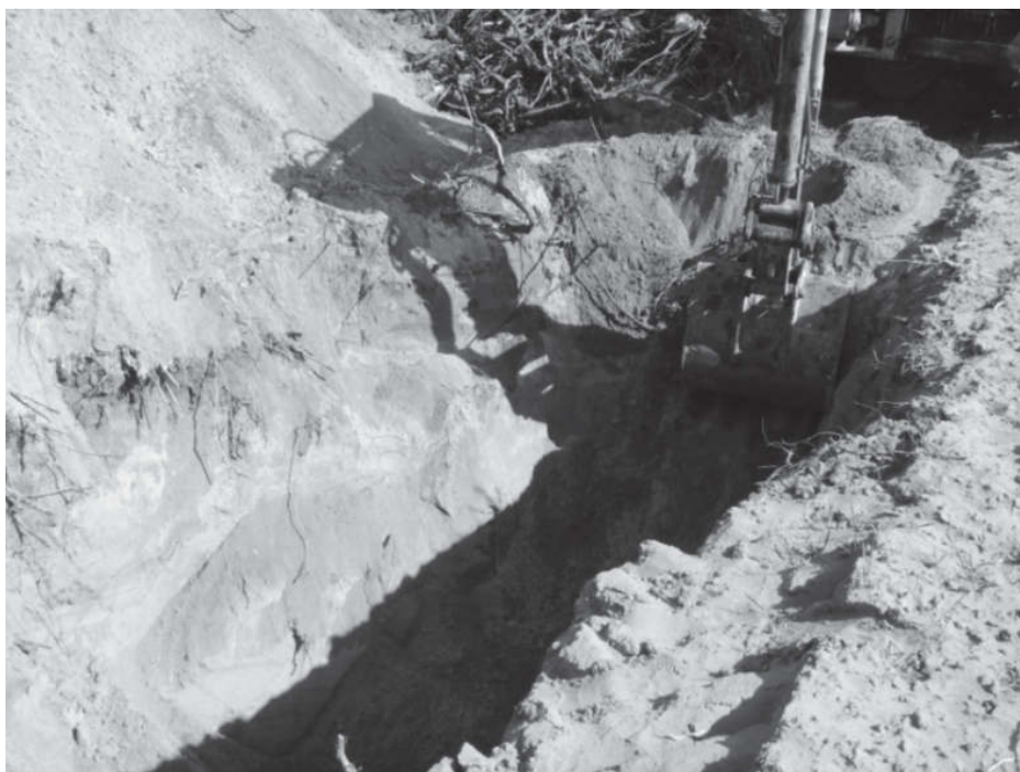
Rys. 9. Wykop pod barierę Fig. 9. Excavation for barrier
