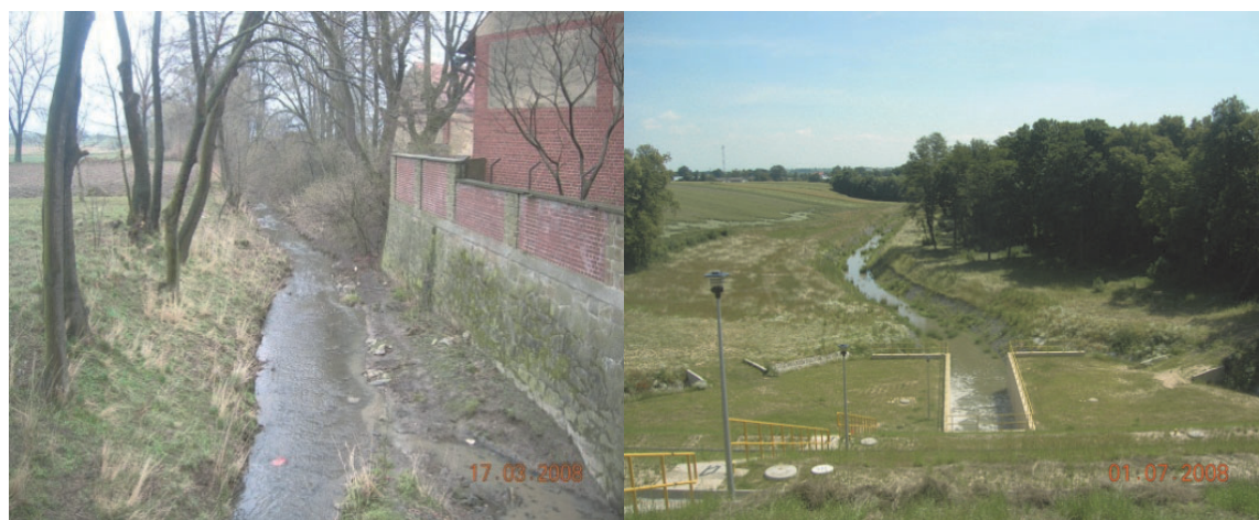
Rys. 3. Troja na dopływie do zbiornika (po lewej) i na odpływie ze zbiornika Włodzienin
