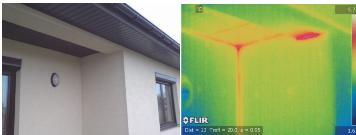
Rys. 4. Elewacja wschodnia budynku – termogram nr 3
