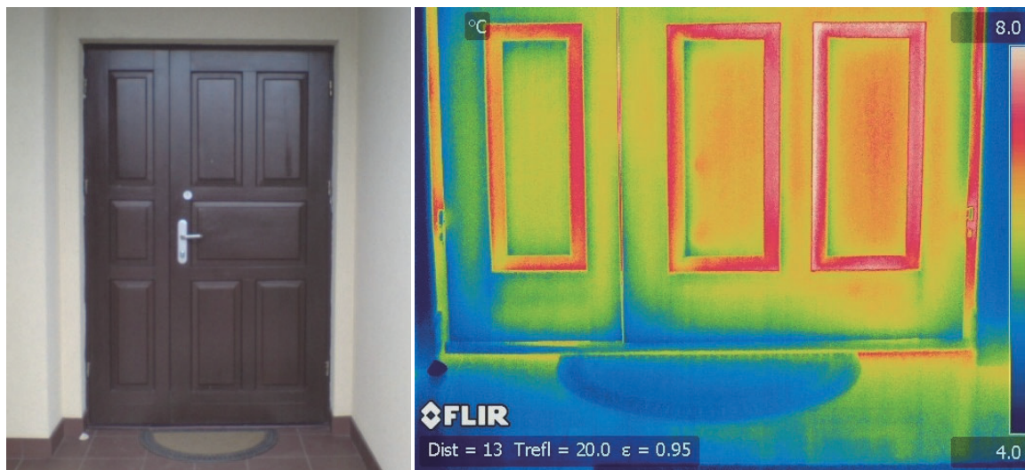
Rys. 2. Elewacja zachodnia budynku – termogram nr 1
