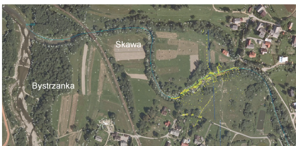
Rys. 1. Widok z lotu ptaka na Skawę w rejonie ujścia Bystrzanki
