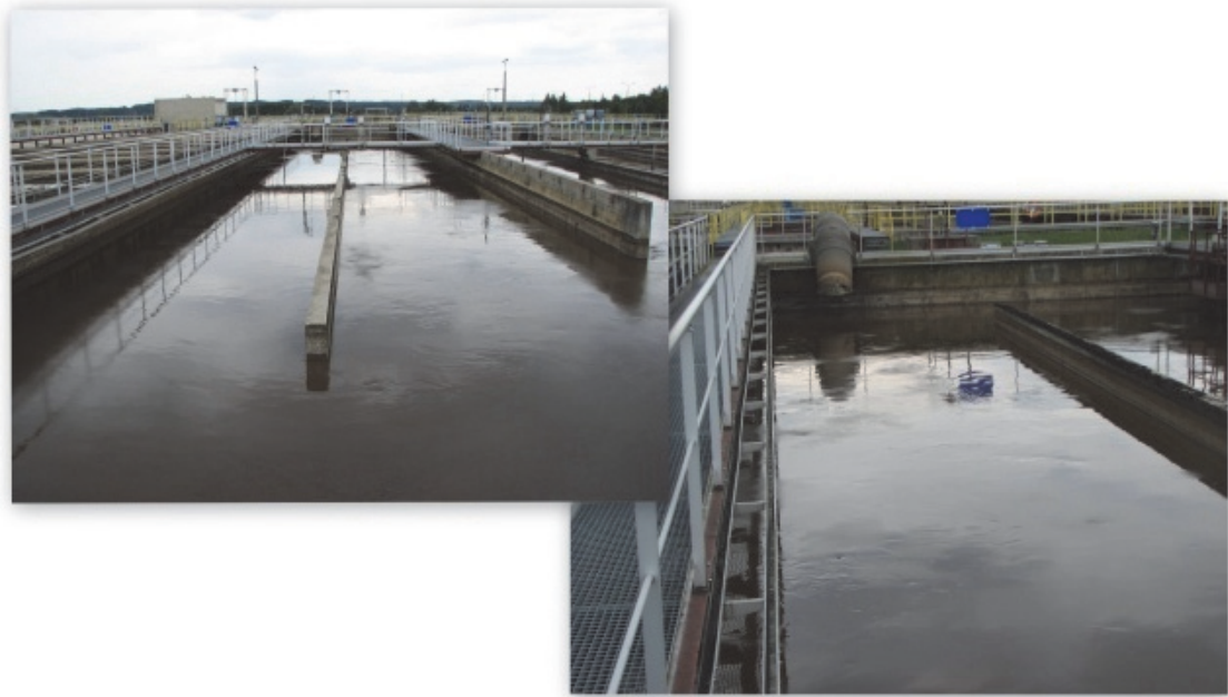
Rys. 3. Komora predenitryfikacji
