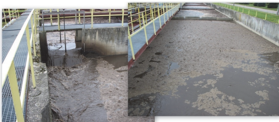
Rys. 7. Strefa denitryfikacji i kanał recyrkulacji wewnętrznej Fig. 7. Denitrification zone and internal recirculation channel
