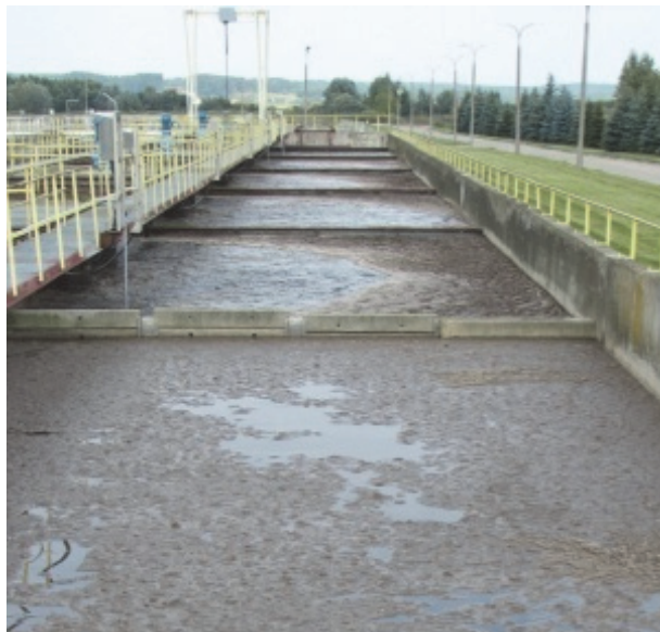
Rys. 6. Komora osadu czynnego Fig. 6. Sludge activated chamber
