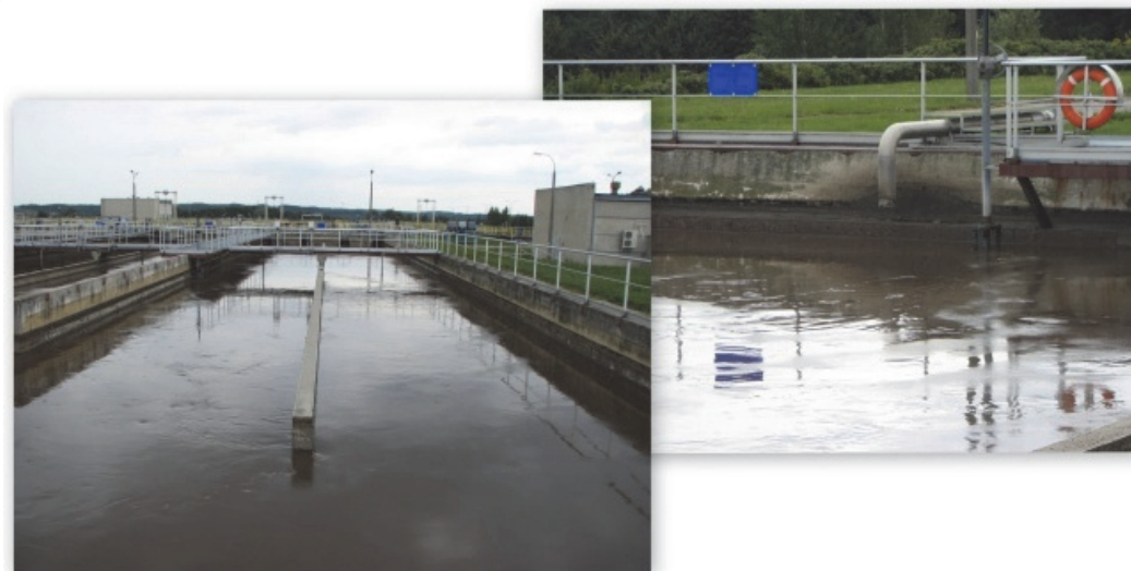
Rys. 4. Komora defosfatacji
