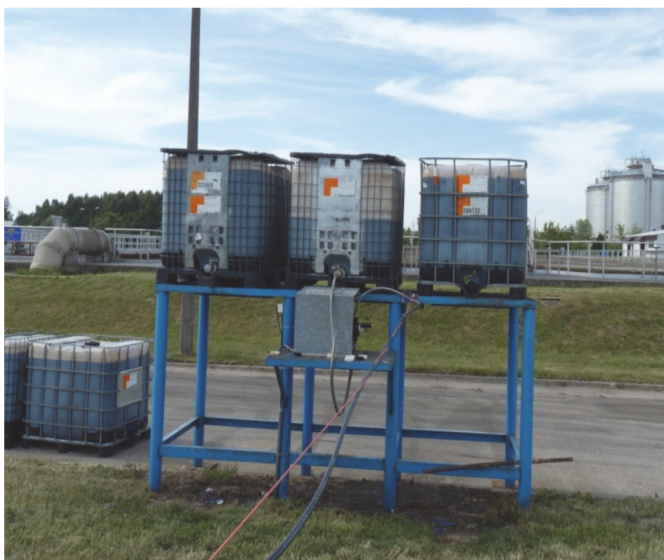
Rys. 1. Instalacja do dawkowania preparatu Brenntaplus VP1
