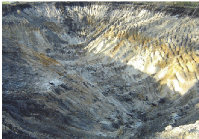
Rys. 5. Wykop po wybraniu skażonej gleby, miejsce poboru drugiej serii próbek (Przygucki 2011)
