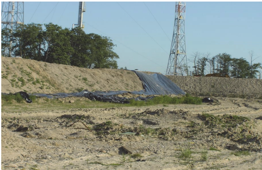
Rys. 10. Pryzma gleby po zakończonej bioremediacji (Przygucki 2011) Fig. 10. Prism soil after completion of bioremediation
