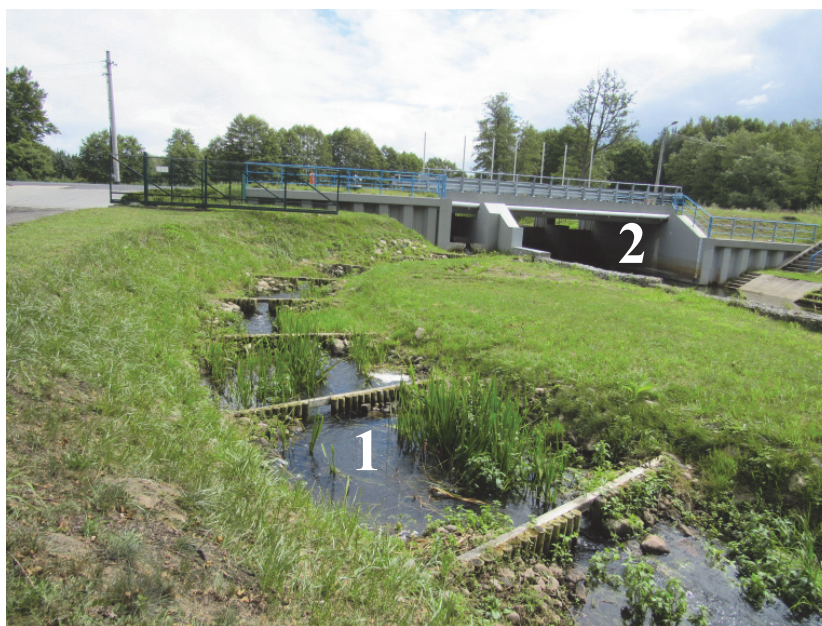
Rys. 1. Stopień wodny Skórka (1 – przepławka, 2 – jaz)
