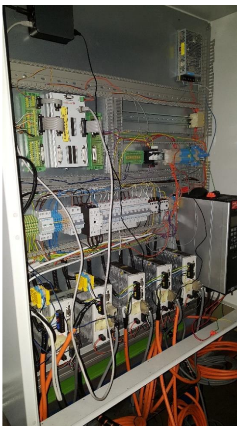
Rys. 68. Widok wnętrza szafy sterowniczej pięcioosiowej specjalnej szlifierki CNC do kształtowania ostrzy technicznych
