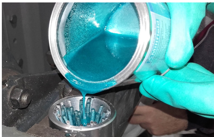
Rys. 3.10. Zalewanie końcówki linowej przy użyciu żywicy Wirelock
