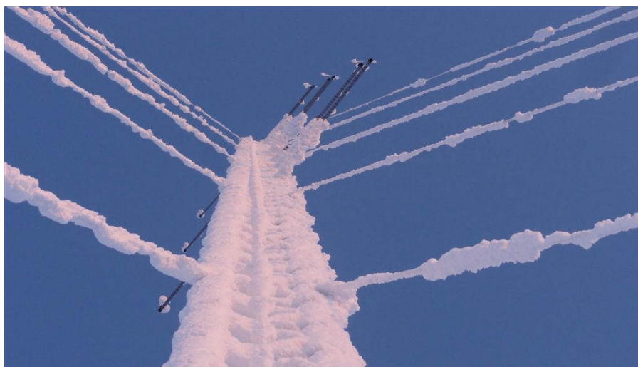
Rys. 1.24. Oblodzenie na maszcie w Finlandii (fot. WINDHUNTER)
