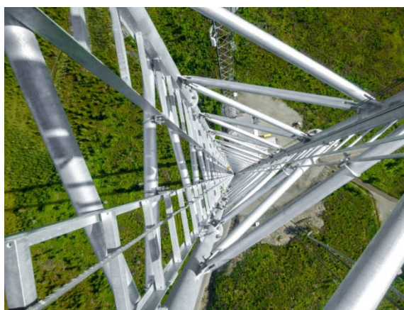
Rys. 1.7. Maszt o trzonie trójpasowym w Tåsjö w Szwecji o wysokości 323 m [250]
