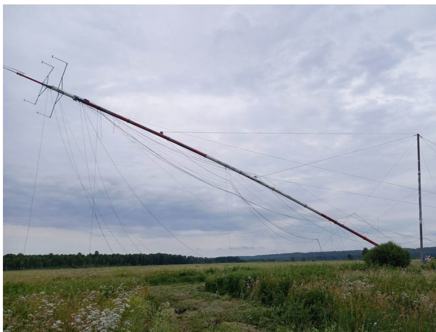
Rys. 1.11. Demontaż masztu pomiarowego w Głównych
