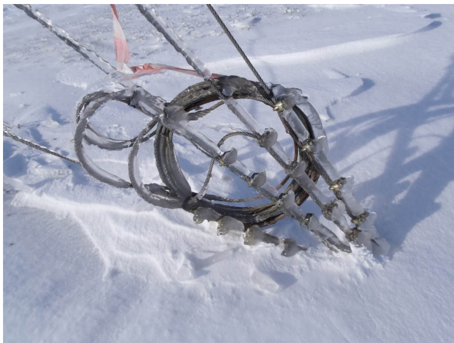
Rys. 1.25. Oblodzone zakotwienie odcigów masztu na Kaszubach (fot. WINDHUNTER)
