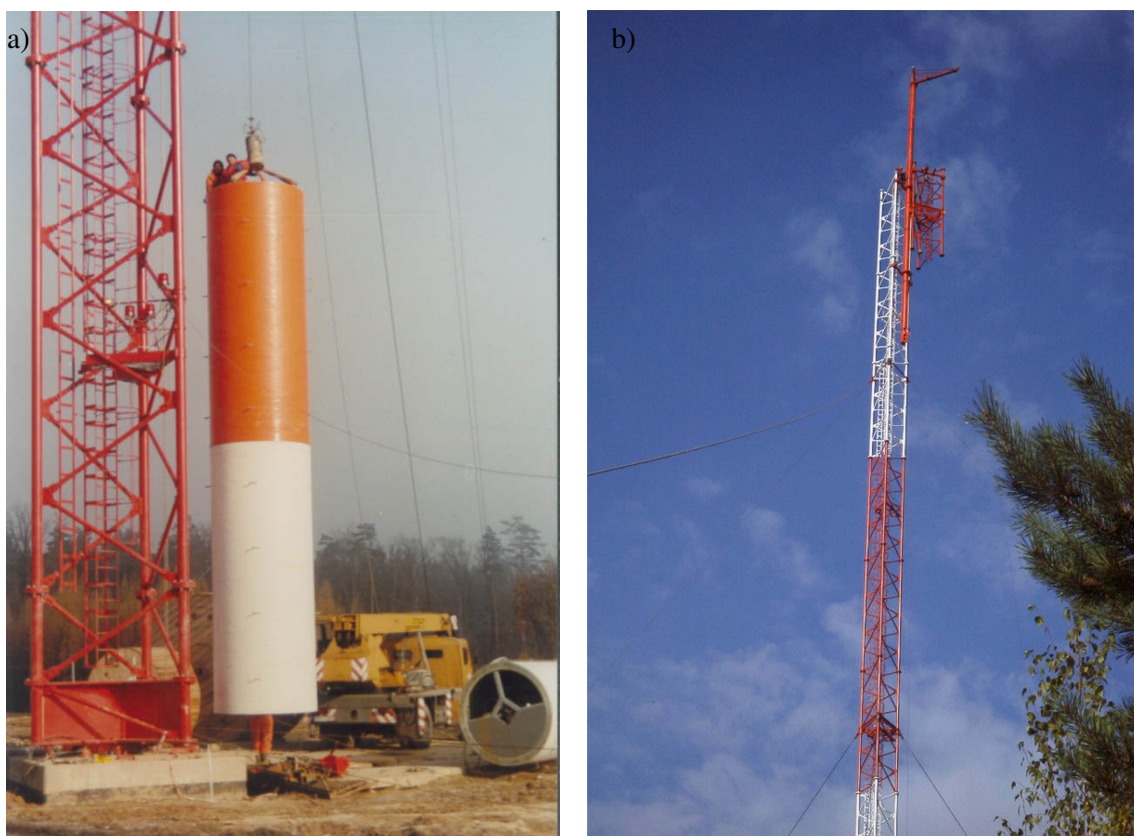
Rys. 1.4. a) Montaż masztu RTCN Przysucha/ Kozłowiec b) żuraw pełzający do montażu masztów firmy „Perfekt Werner” [250]
