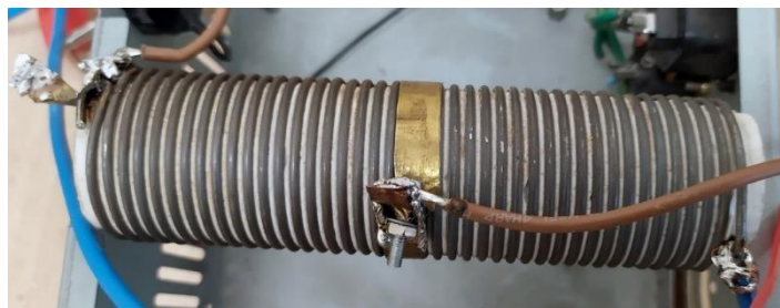
Rys. 5.5. Rezystor z drutu oporowego na ceramicznym karkasie
