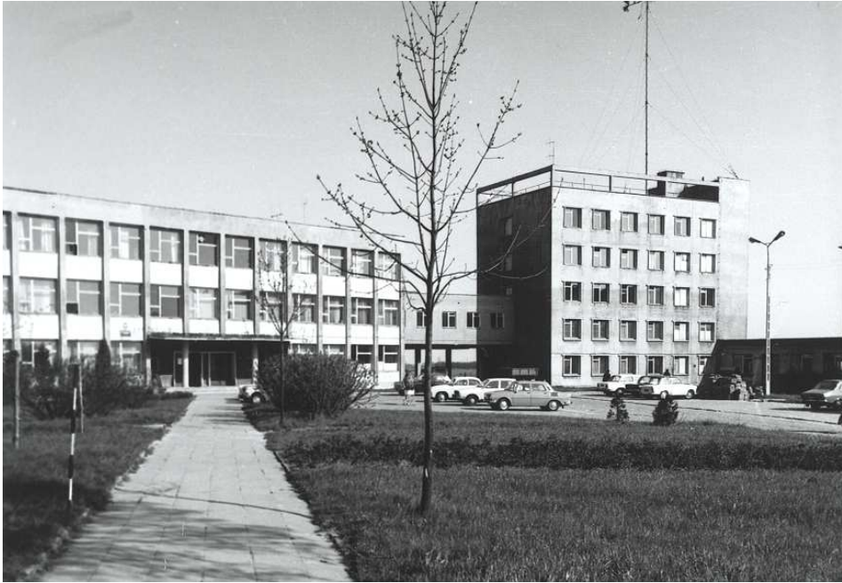
Gmach główny Wyższej Szkoły Inżynierskiej przy ul. Raławickiej w roku 1970
