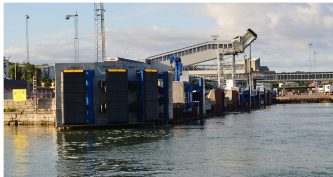
Rys. 21. Odbijacze morskie wykonane w tworzyw polimerowych. Nabrzeże promowe portu Visby na Gotlandii (Szwecja) autor T. Rydzkowski
