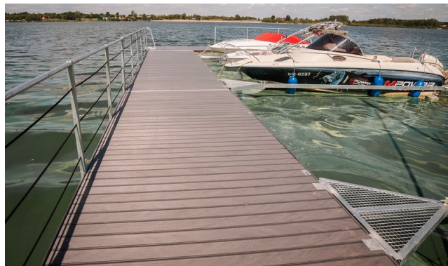
Rys. 20. Pływający pomost wykonany z WPC
