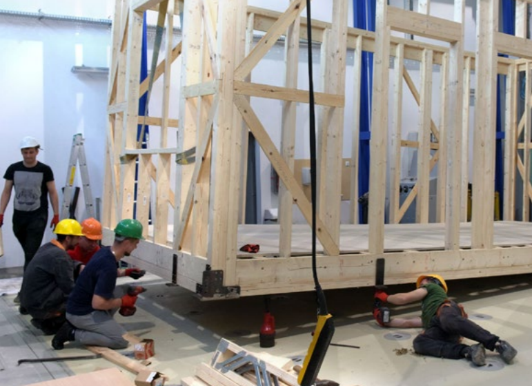
Prace przy montażu modelu badawczego w uczelnianym laboratorium
