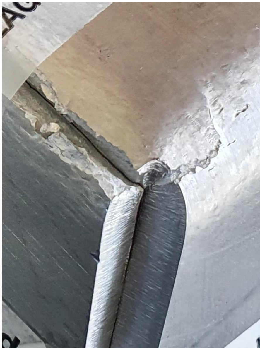
Rys. 1. Obraz z widocznym całkowitym pęknięciem materiału wzdłuż linii gięcia spowodowanym niepoprawnym doбором narzędzi gnących
