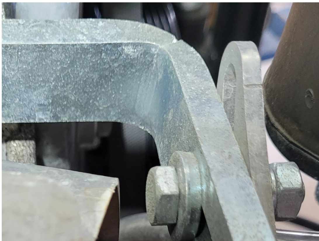
Rys. 9. Obraz pęknięcia zmęczeniowego w strefie gięcia
