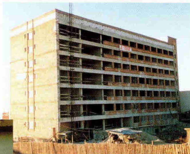
Obiekt w trakcie budowy, przejęty przez Uczelnię w 1994 roku przy ówczesnej ul. K. Marksa, później przemianowanej na ul. Kwiatkowskiego
