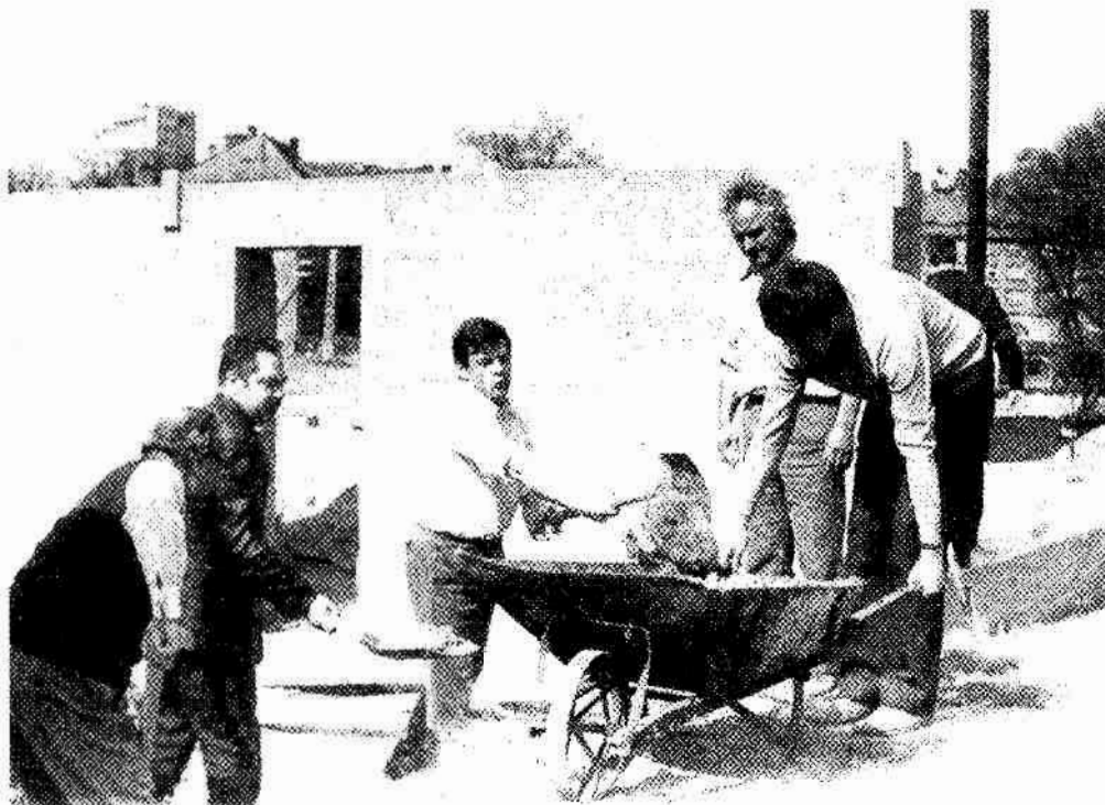
Prace społeczne przy budynku F
