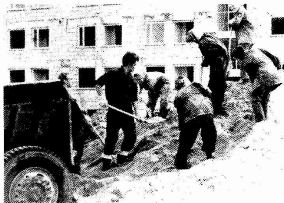
Prace przy budowie akademików – rok 1970
